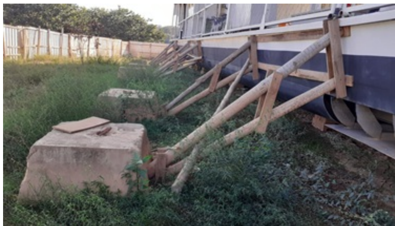
Imagem 02 - Estrutura de escoramento lateral da embarcação Fonte: Acervo do IEPHA/MG - 30/07/2022
