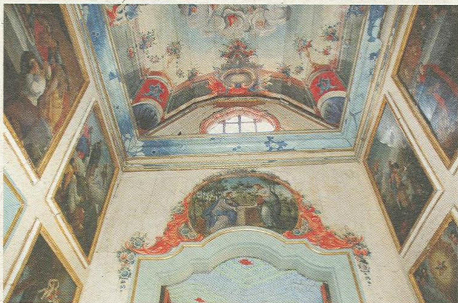
Vista do interior da capela
