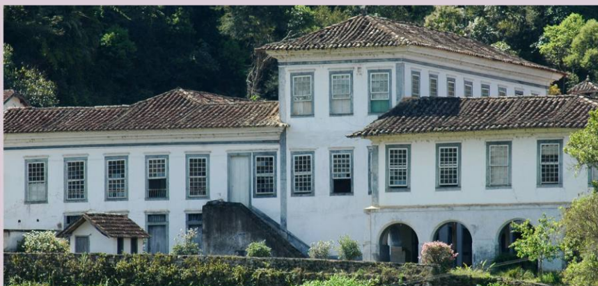
Vista da fachada frontal da sede da fazenda
