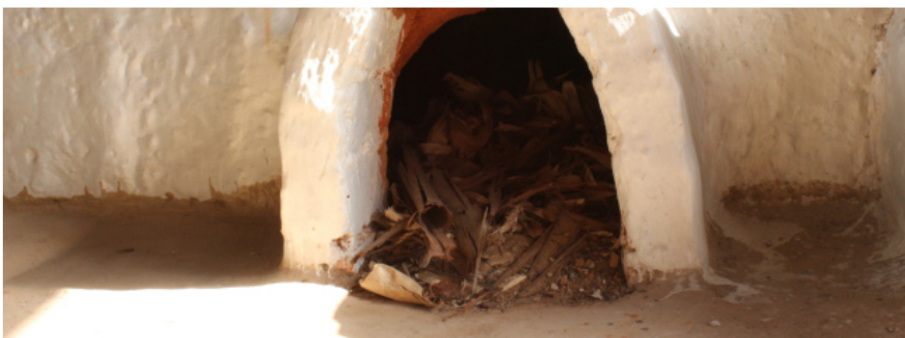
Fig. 51: Boca do forno, onde as lenhas são colocadas. Acervo: lepha/MG
