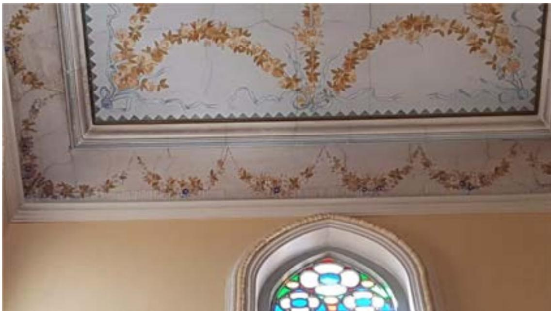
**Figura 40:** Forro Lado Epístola. Detalhe das manchas de umidades na pintura e trincas no suporte. Fonte: IEPHA-MG, junho de 2021.
