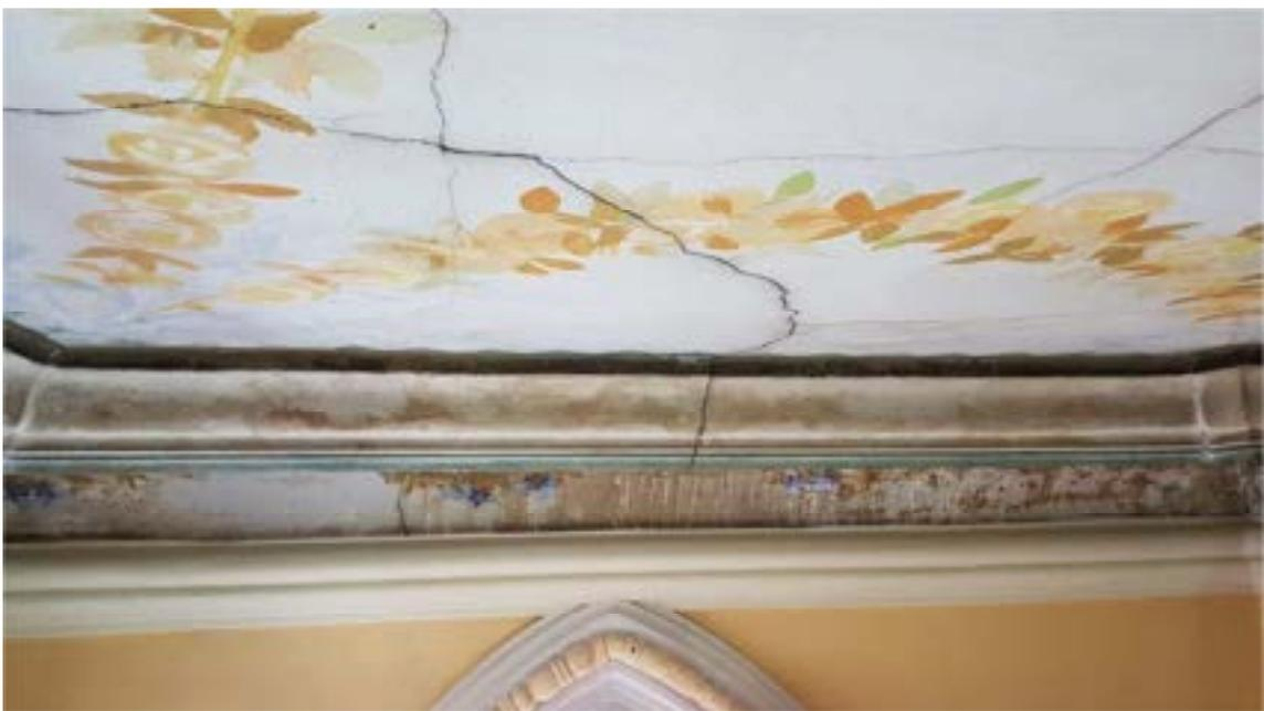
**Figura 38:** Forro Lado Evangelho. Detalhe das trincas no suporte e manchas de umidade na pintura. Fonte: IEPHA-MG, junho de 2021.
