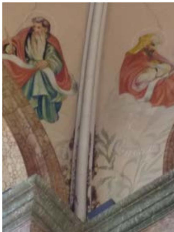
**Figura 44:** Forro central. Ponto com manchas de infiltração e esmaecimento da camada pictórica. Fonte: IEPHA-MG, julho de 2022.
