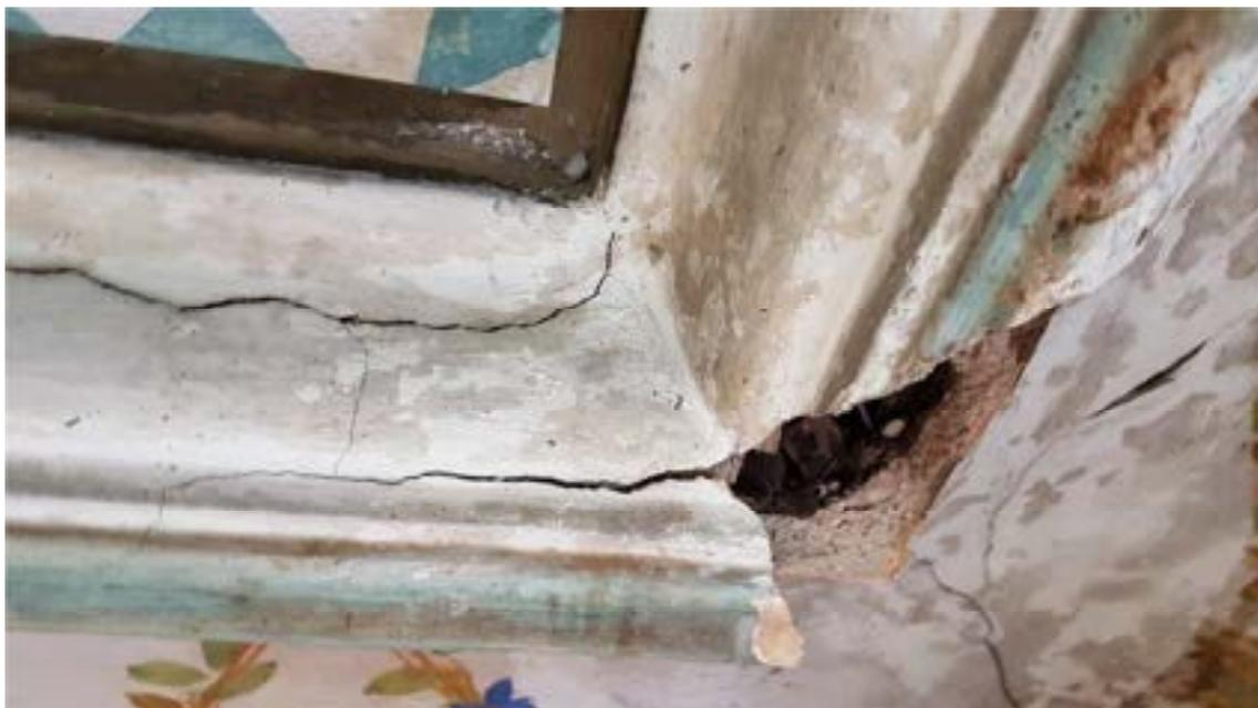
**Figura 39:** Forro Lado Evangelho. Detalhe da perda de parte da cimalha e trincas no suporte. Fonte: IEPHA-MG, junho de 2021.
