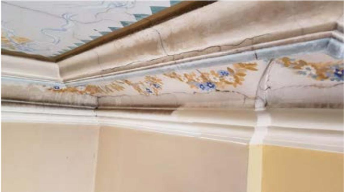
**Figura 33:** Forro Lado Evangelho. Detalhe das manchas de umidades na pintura e trincas no suporte. Fonte:IEPHA-MG, junho de 2021.
