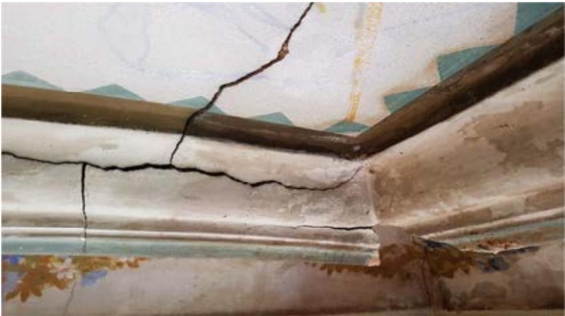
**Figura 36:** Forro Lado Evangelho. Detalhe da perda de parte da cimalha, trincas no suporte e manchas de umidade na pintura. Fonte: IEPHA-MG, junho de 2021.
