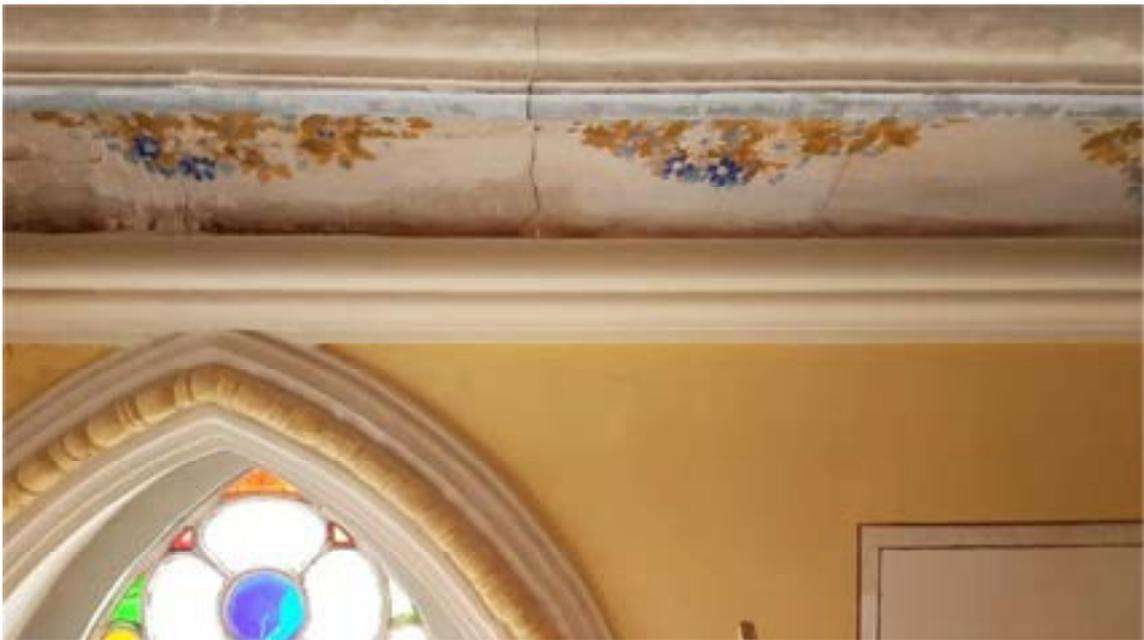
**Figura 34:** Forro Lado Evangelho. Detalhe das manchas de umidades na pintura e trincas no suporte. Fonte: IEPHA-MG, junho de 2021.
