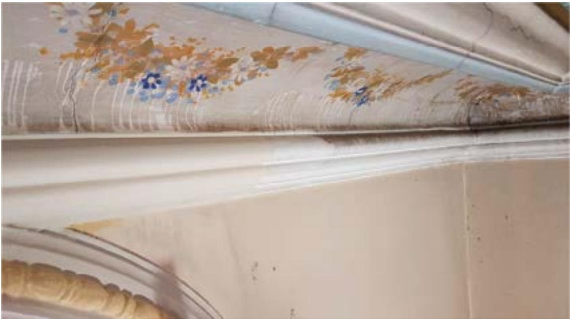
**Figura 35:** Forro Lado Evangelho. Detalhe das manchas de umidades e sujidades na pintura. Fonte: IEPHA-MG, junho de 2021.
