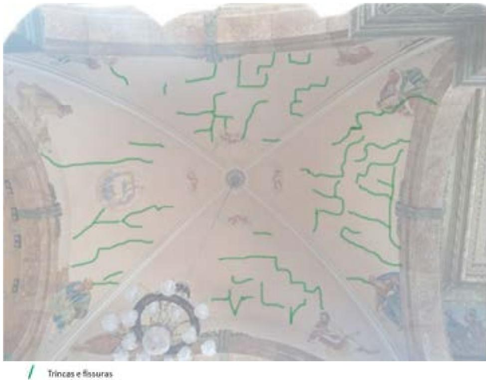
**Figura 48:** Forro central. Mapeamento das trincas.
