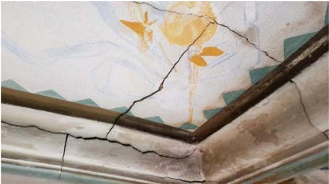
**Figura 37:** Forro Lado Evangelho. Detalhe das trincas no suporte e manchas de umidade na pintura. Fonte: IEPHA-MG, junho de 2021.
