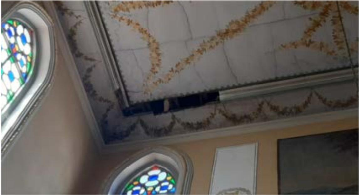
**Figura 42:** Forro Lado Epístola. Detalhe da lacuna na moldura interna da cimalha. Fonte: IEPHA-MG, agosto 2022.
