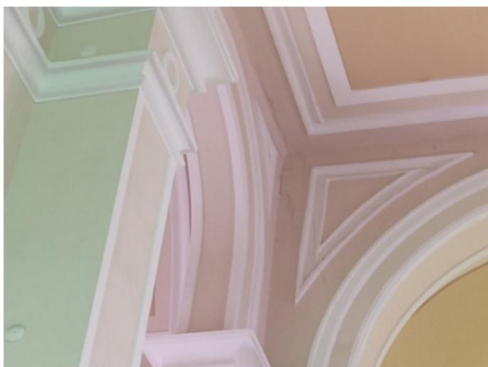
1. **Infiltrações:** Verificam-se pontos de infiltrações nas naves laterais e nos pilares laterais. Há necessidade de verificação da eficiência do telhado ou se há outro tipo de patologia.
